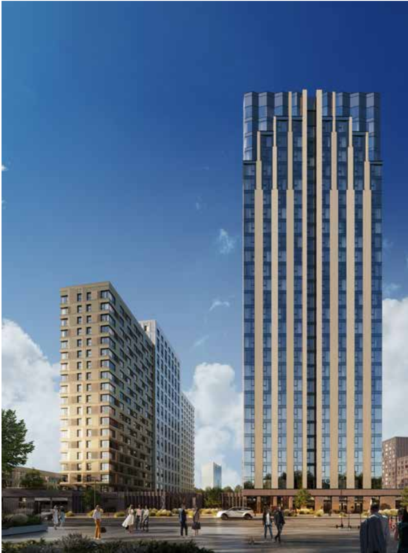
Жилой район ALIA, III очередь
